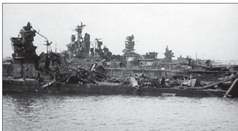
«Сакава» после первого испытания атомной бомбы на Бикини. Носовая надстройка удержалась на месте, все, расположенное в корму — смято взрывной волной. Корабль оседает кормой и вскоре затонет
