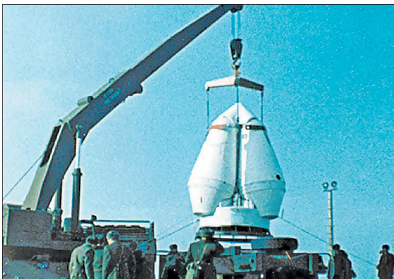
Установка разделяющейся головной части на МБР Р-36
